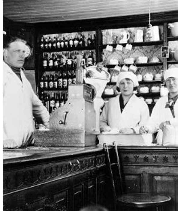
Juslinin kauppateiden risteyksessä suunnitteen nykyisen Sävy-kampaamon kohdalla oli kylän keskus. Rakennus purettiin 1970-luvun alussa.
